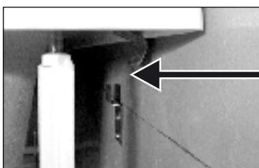
Настенный фиксатор предлагается для усиления жесткости установленной ванны.
