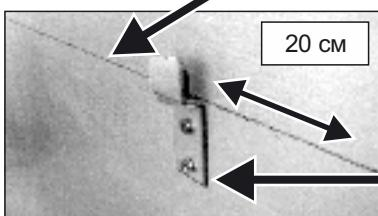
Отодвинуть ванну и приступить к монтажу фиксирующих пластин. Сделать отверстия в стене диаметром 6 мм. Вставить дюбеля и при помощи саморезов закрепить пластины. **Внимание!** Две пластины должны находиться на расстоянии 20 см от угла, а две другие - на расстоянии 20 см от краев ванны.
