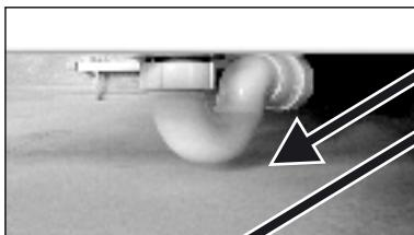
Установить ванну на ножки. Край нижней части сифона должен быть на расстоянии не менее 15 мм от пола. В верху ванны под бортиками необходимо отметить линию - границу нахождения верхней части фиксирующей пластины.
